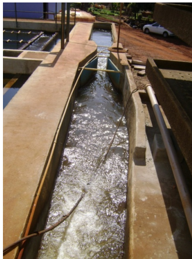
Figura 43: Entrada de água e Calha Parshal
