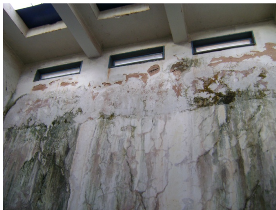
Figura 31: Infiltração nas paredes da casa de bombas
