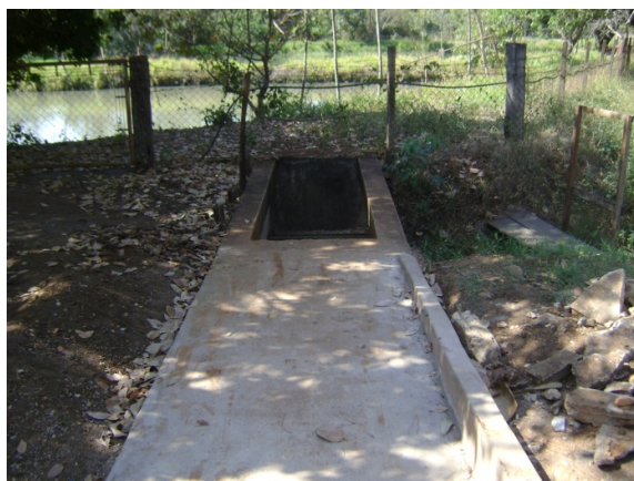
Figura 12: Canal após gradeamento e tubulação enterrada
