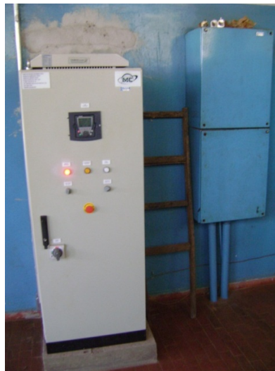
Figura 17: Inversor de frequência
