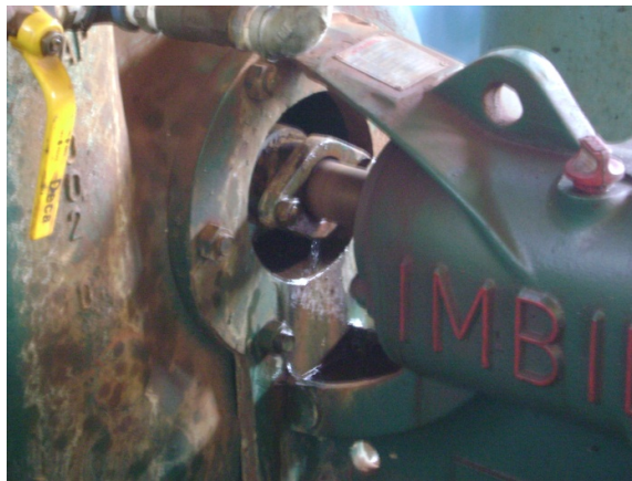
Figura 16: Vazamento Bomba 01
